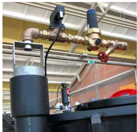
Füllereinheit mit Absperrorgan
