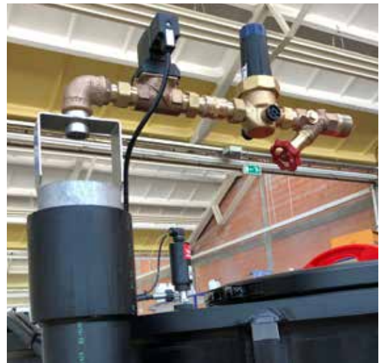
Füllereinheit mit Absperrorgan
